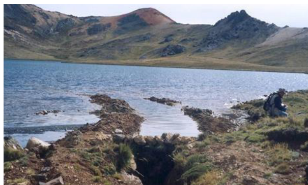
Fig. 06. Construcción y mantenimiento de canales de drenaje.
