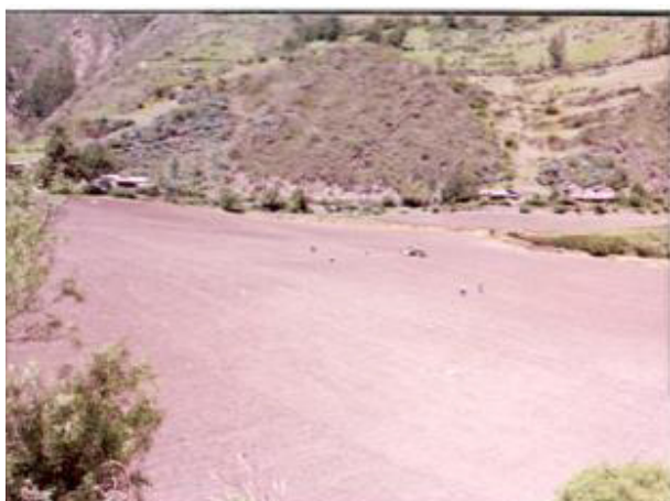
Fig. 04. Nivelación del terreno para buen riego.
