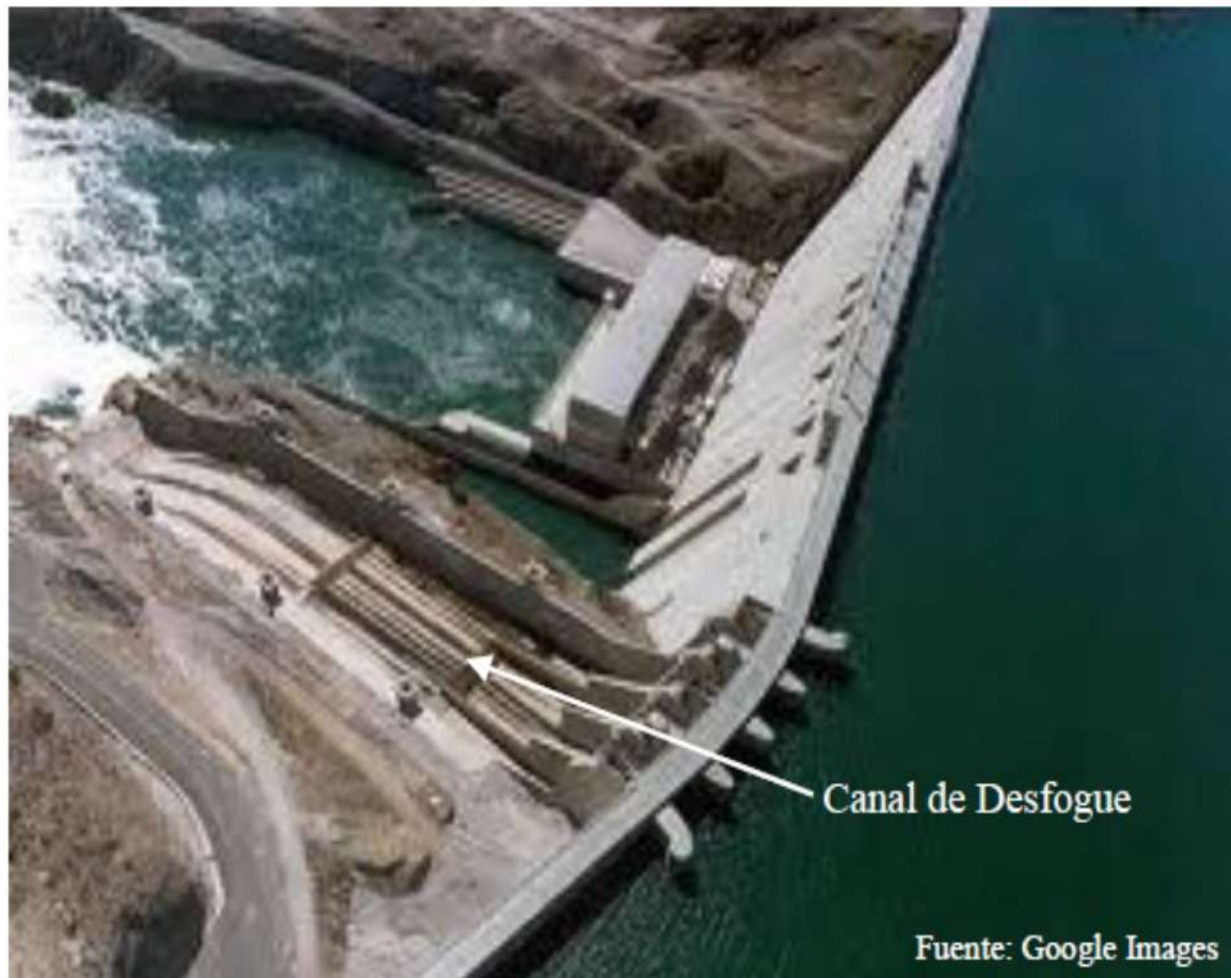
Figura 8.11: Canal desfogue presa hormigón de gravedad.
