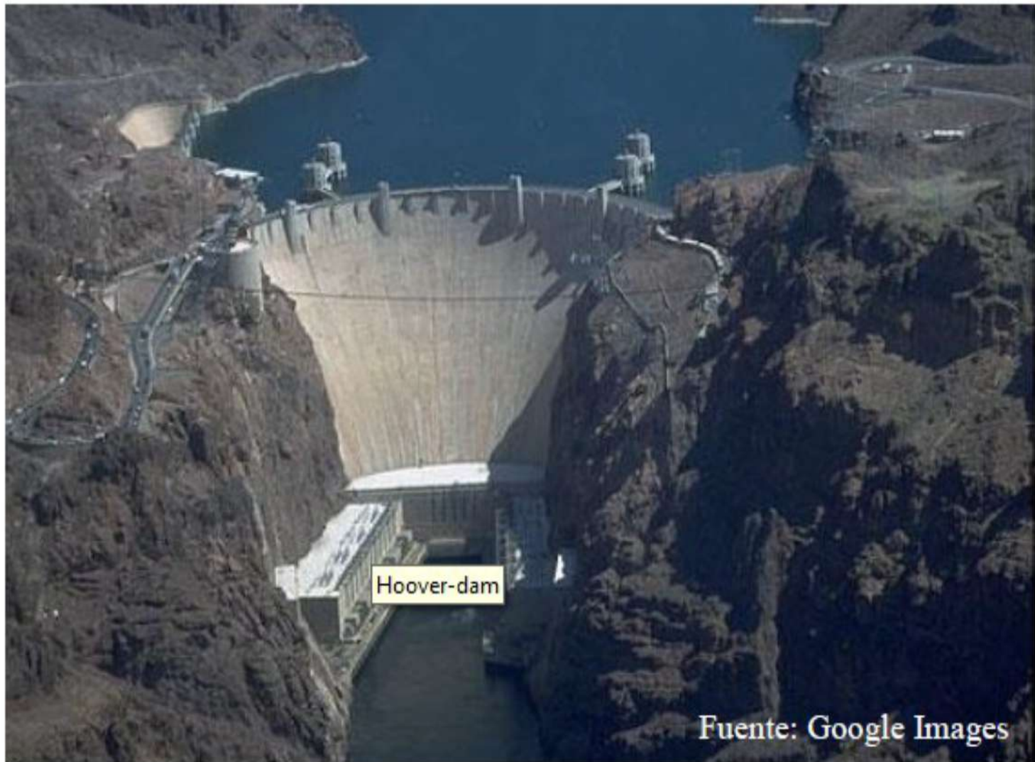
Presa Hoover, tipo bóveda, Arizona y Nevada, Estados Unidos.
