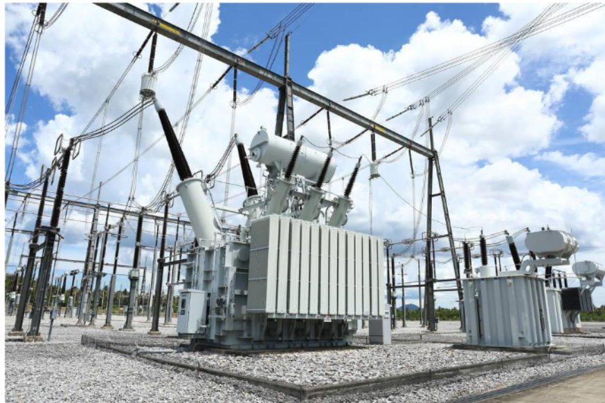
Representación de subestación elevadora
