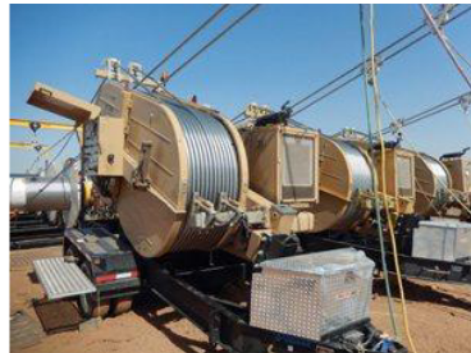
Fig. 1. Equipo de encordado de líneas de transmisión Tesmec
