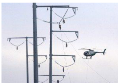
Fig 2. Un helicóptero inicia el proceso de encordar una línea de transmisión de alta tensión
