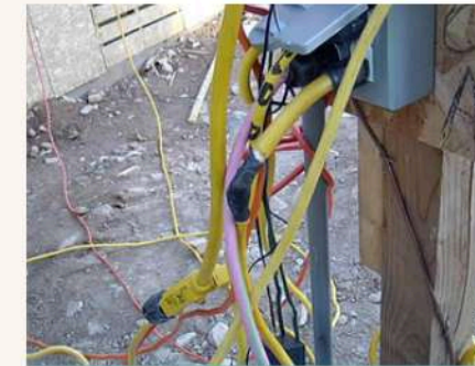
Cables energizados en mal estado
