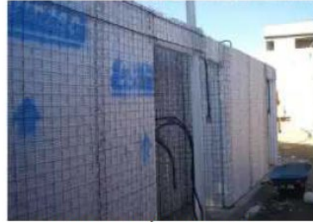
INSTALACIÓN OCULTA EN PANELES DE DUROPORT
