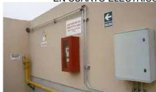
INSTALACION SOBREPUESTA SOBRE MUROS
