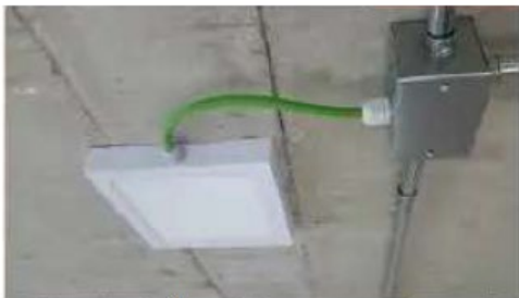
INSTALACIÓN SOBREPUESTA SOBRE LAS LOSAS DE CONCRETO.
