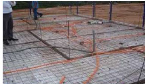
INSTALACIÓN OCULTA EN FUNDICIÓN
