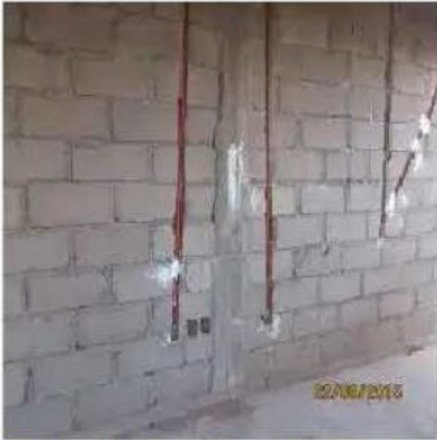
INSTALACIÓN OCULTA EN MUROS. DE MAMPOSTERÍA
