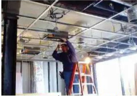
INSTALACIÓN OCULTA EN EL CIELO FALSO
