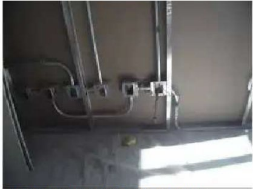
INSTALACIÓN OCULTA EN TABIQUES DE TABLAYESO
